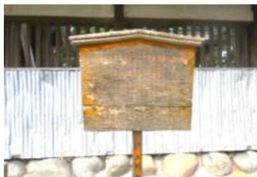
劣化した案内板(設置後6年)
