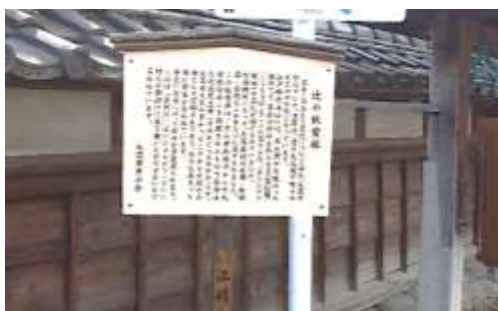
ビス止めした案内板（更新後6年）
